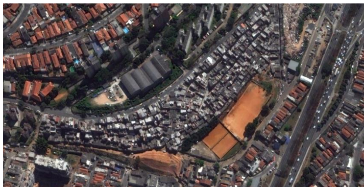
Figura 12 Foto aérea do Boqueirão, 2012. Parcela de casas à beira do córrego já retirada. (Fonte: Google Earth. Acesso em fevereiro de 2018.)
